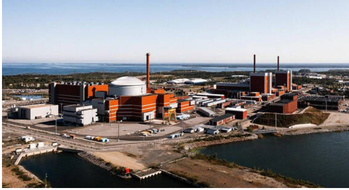
Soldaki Finlandiya Olkiluoto 3 yeni nükleer santrali (arka planda eskiler)
