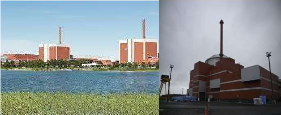
Şekil 1. Fransa Flamanville3 reaktörü gibi, Finlandiya Olkiluoto-3 reaktörü de EPR reaktörüdür. Finlandiya reaktörü 2023'den beri elektrik üretmektedir.
