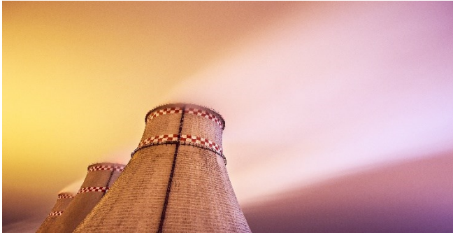
Nükleer reaktörlerin radyoaktif olmayan ırmak suyu soğutma kuleleri
