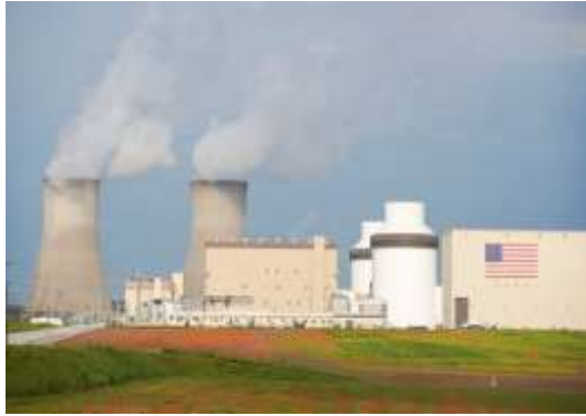
ABD Vogtle Westinghouse AP1000 büyük nükleer reaktörleri ve havuzlu pasif güvenlik sistemi
